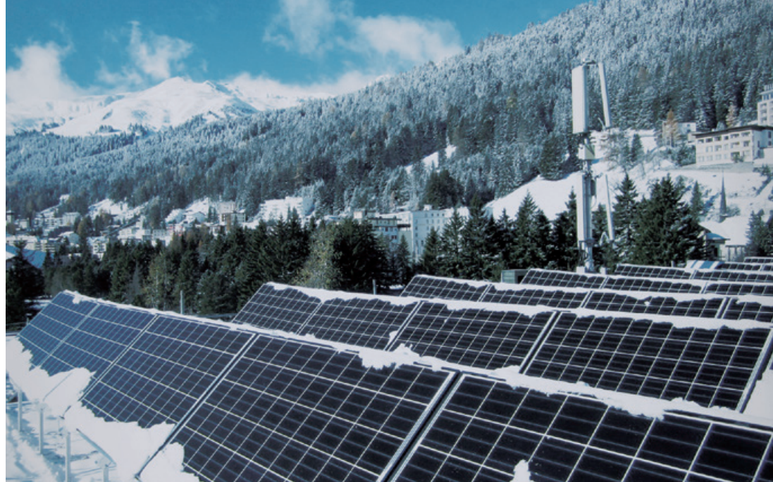
다보스 콩그레스센터 지붕(1,000m 2 )에 설치된 한화의 태양광 모듈
